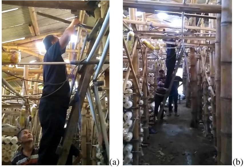
Gambar 5.8.. Pemasangan sistem di kumbung jamur lokasi Malang
